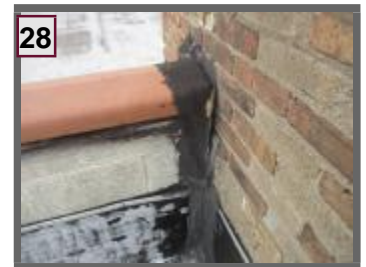
28 Mig shift repairs exist
